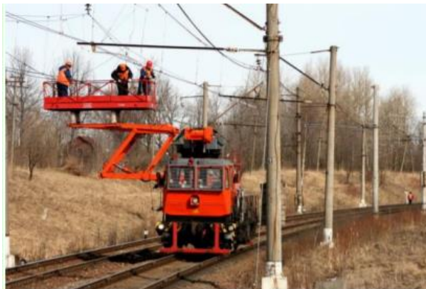
Рисунок 2.10. Выполнение работ по ремонту контактной сети
