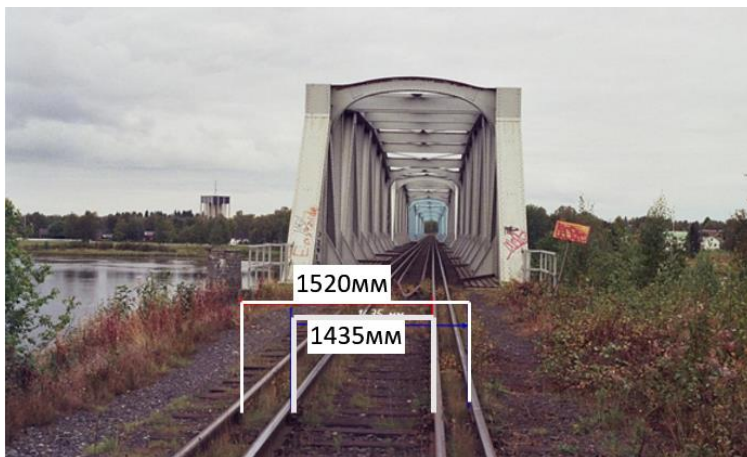
Рис. 2.7. Совмещенная колея на границе Швеции и Финляндии: широкая (1520 мм) и узкая (1435 мм)
